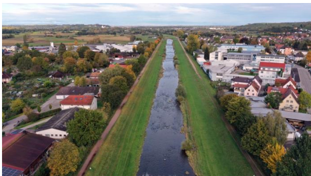
Abb. 5-15: Gewässerabschnitt im Doppeltrapezprofil. Abgesehen von stellenweise vorhandenem Buschwerk fehlen Hochwasserrefugien (Quelle: HYDRA, Peter Rey).
